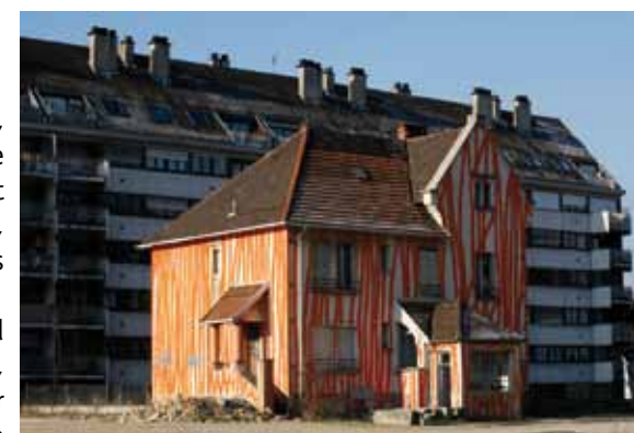
LA DÉMOLITION DE CETTE MAISON INOCCUPÉE ÉTAIT INDISPENSABLE POUR L'AMÉNAGEMENT DU SITE.
